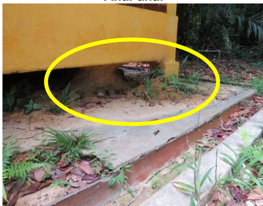
Gambar 3.26 Keadaan Bawah Calet Yang Diserang Anai-anai
