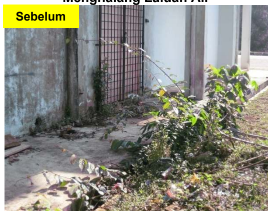
Gambar 5.3 Tumbuhan Menutupi Longkang Menghalang Laluan Air
