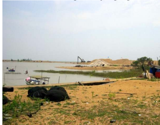
Gambar 2.11 Kerja Mengorek Mendapan Pasir Di Kuala Sungai Tanjung Agas
